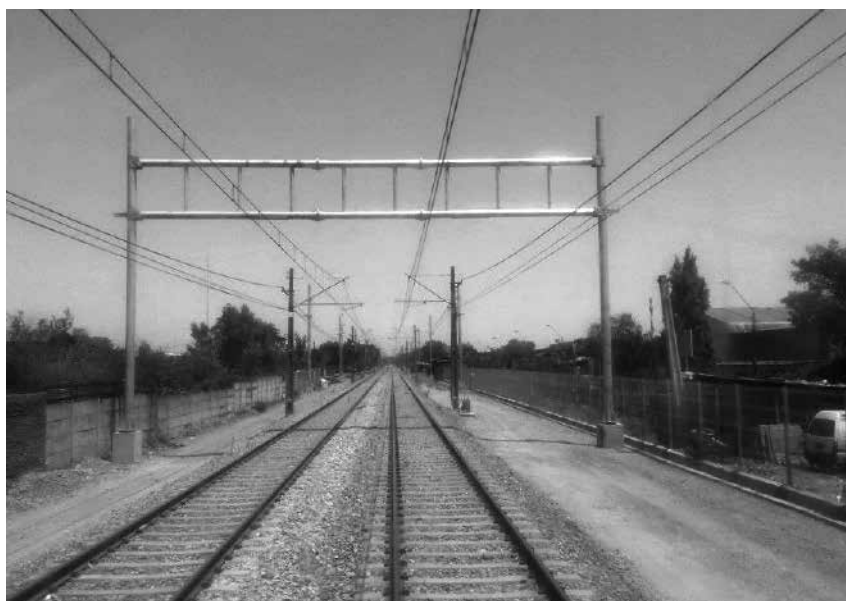
Primer tramo listo frente a Lo Valledor. Diciembre 2013. Foto Cristián Miño.
