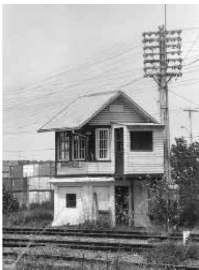
La típica cabina de señales de la estación de carga del ramal con su nombre grabado en el costado: Barrancas.
