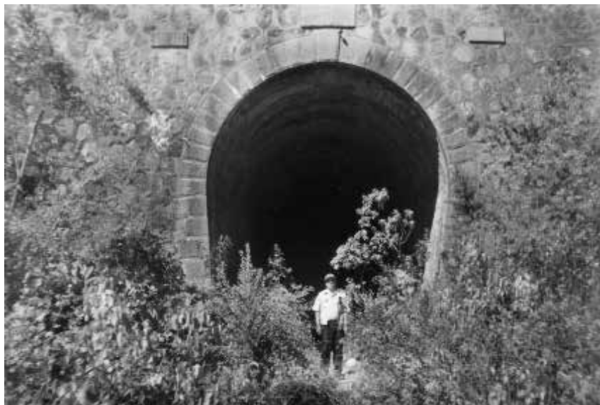
Túnel de El Árbol cubierto de vegetación. Foto y Gentileza José Arriagada, año 1997.
