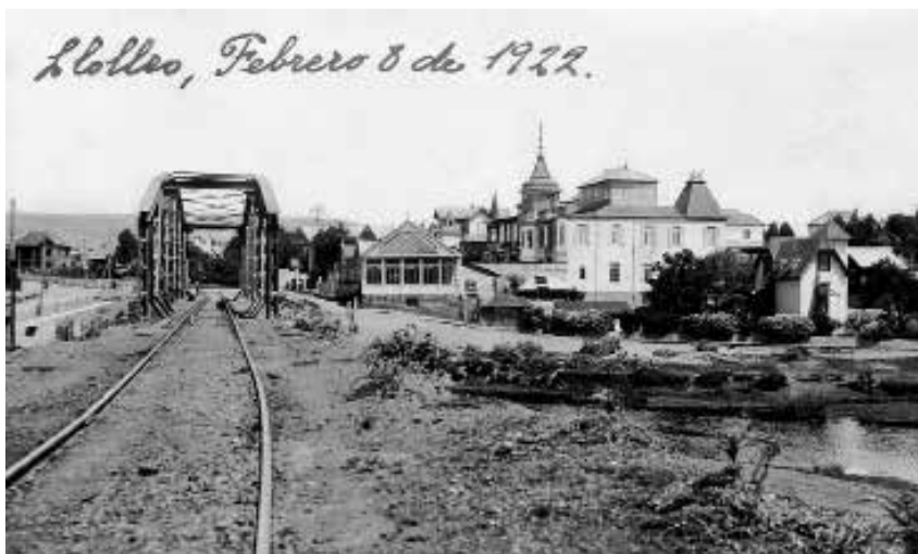
El puente El Canelo, de 200 metros de extensión se encontraba a la salida de la estación Llolleo en dirección a l puerto de San Antonio.
